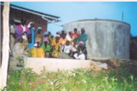
Serbatoio di acque piovane realizzato recentemente
